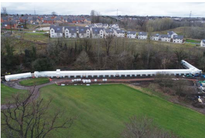
Encapsulation tent for pipe wrapping at Uddingston
